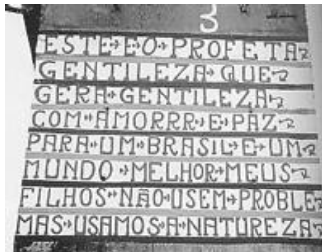
Fig. 1 - escritos em pilastras de viadutos
